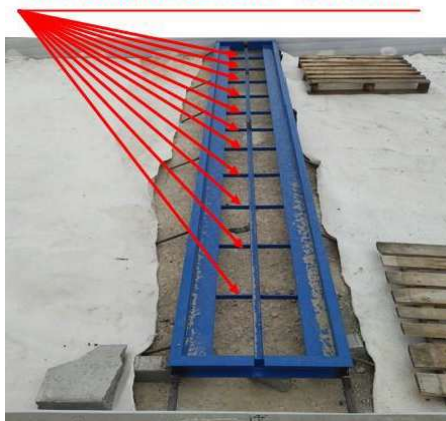
Elementy nr 4: Płaskowniki podtrzymujące podstawy – co 400 mm
